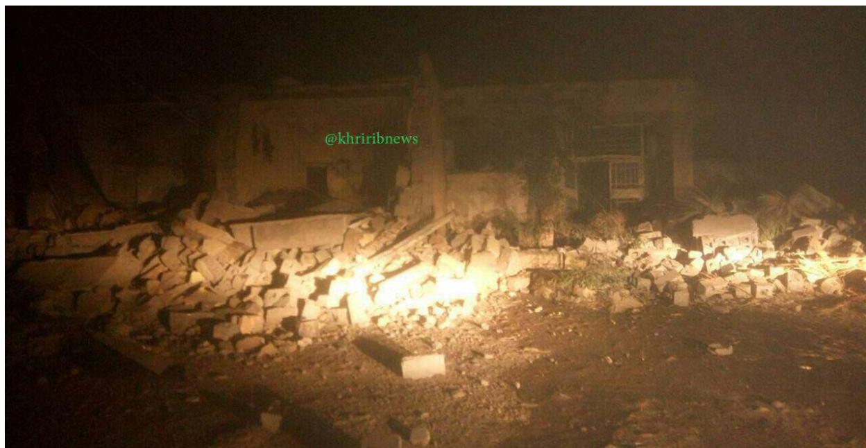
شکل ۴-۷ تخریب دیوار منزل مسکونی در سرپل ذهاب
