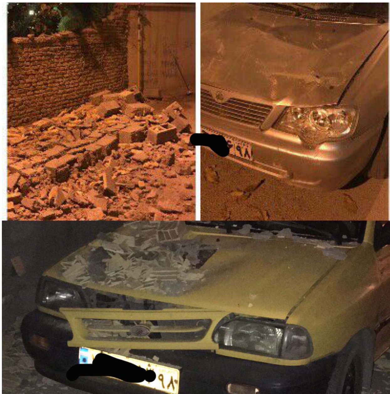
شکل ۴-۹: تخریب دیوار منزل مسکونی و آسیب به خودرو در ایلام
