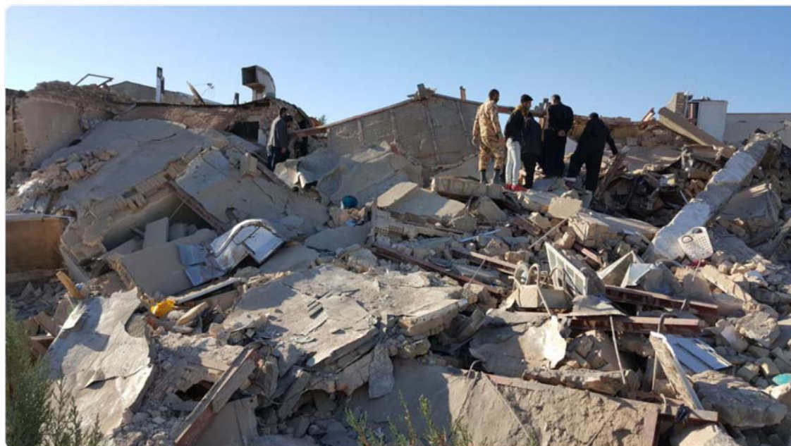
شکل ۴-۲۳: ریزش کامل ساختمان در
