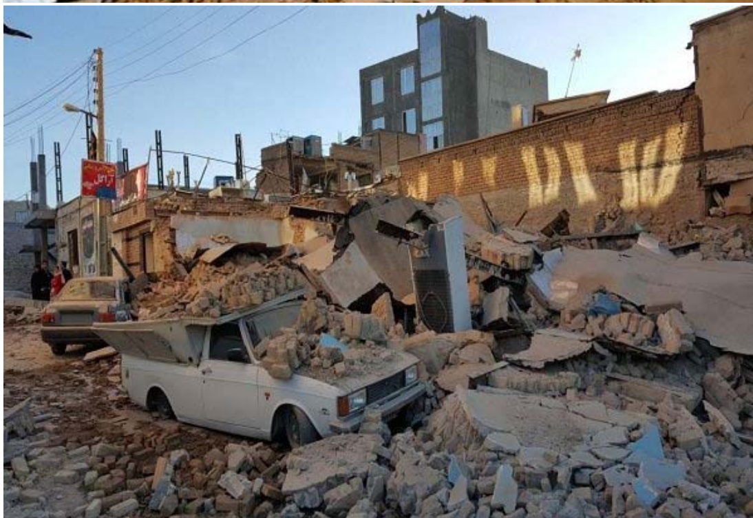
شکل ۴-۱۲: فروریزش دیوار پیرامونی در کرمانشاه
