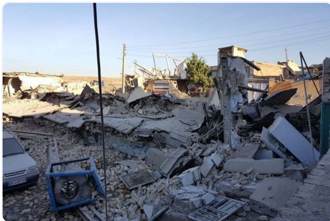
شکل ۴-۲۲: ریزش کامل ساختمان در
