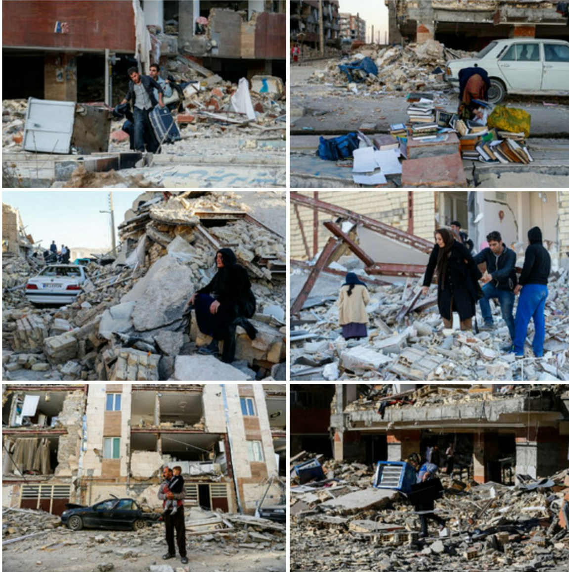
۴-۲۴: تخریب گسترده ساختمانهای شهری در کرمانشاه
