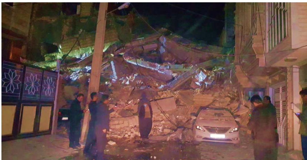
شکل ۴-۱۹: ریزش کامل ساختمان در جوانرود کرمانشاه
